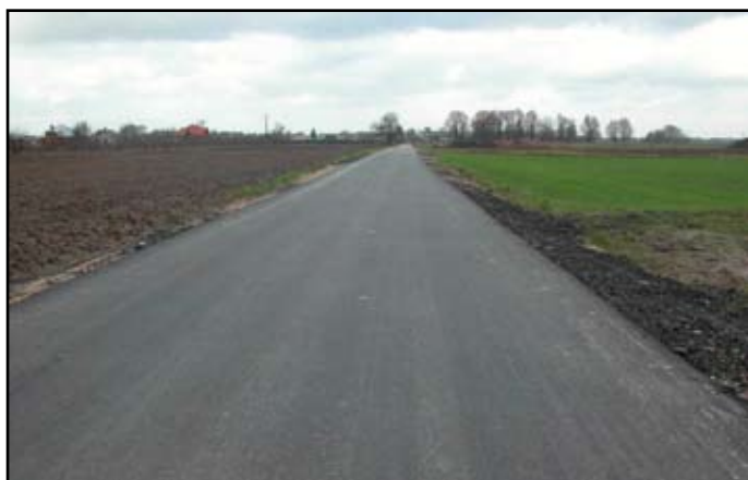
Ulica Krzywa w Kotorydzu po przebudowie
